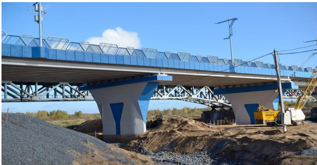
Рисунок 2 – Мост после реконструкции
