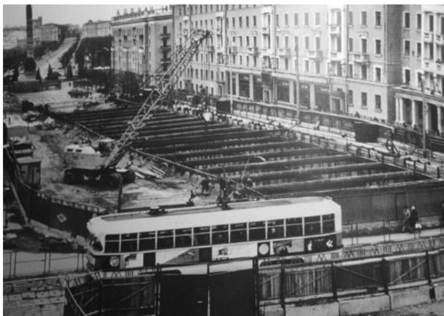
Рисунок 1 – Строительство станции метро «Площадь Победы»
