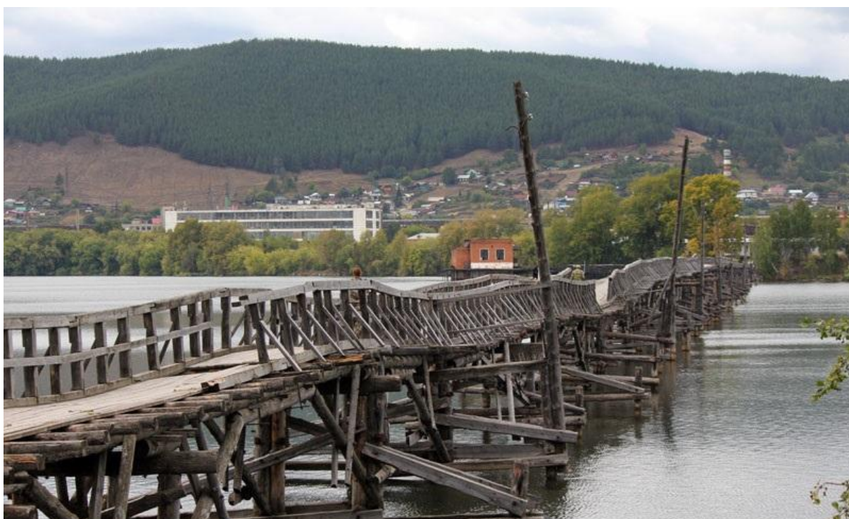
Рисунок 1 – Пример деревянного моста
