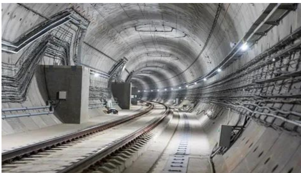
Рисунок 3 – Второй Байкальский тоннель
