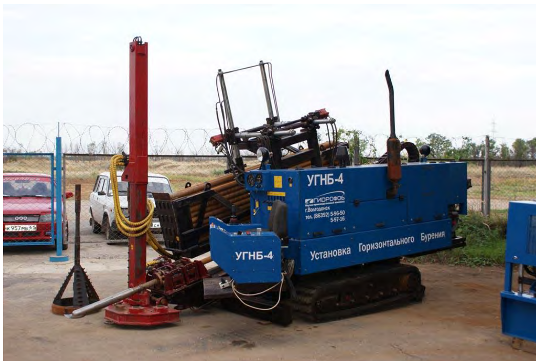
Рисунок 4.42 – Установка горизонтально-направленного бурения
