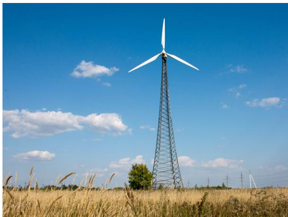
Рис.2. Ветроэнергетическая установка в посёлке Грабники Новогрудского района Гродненской области
