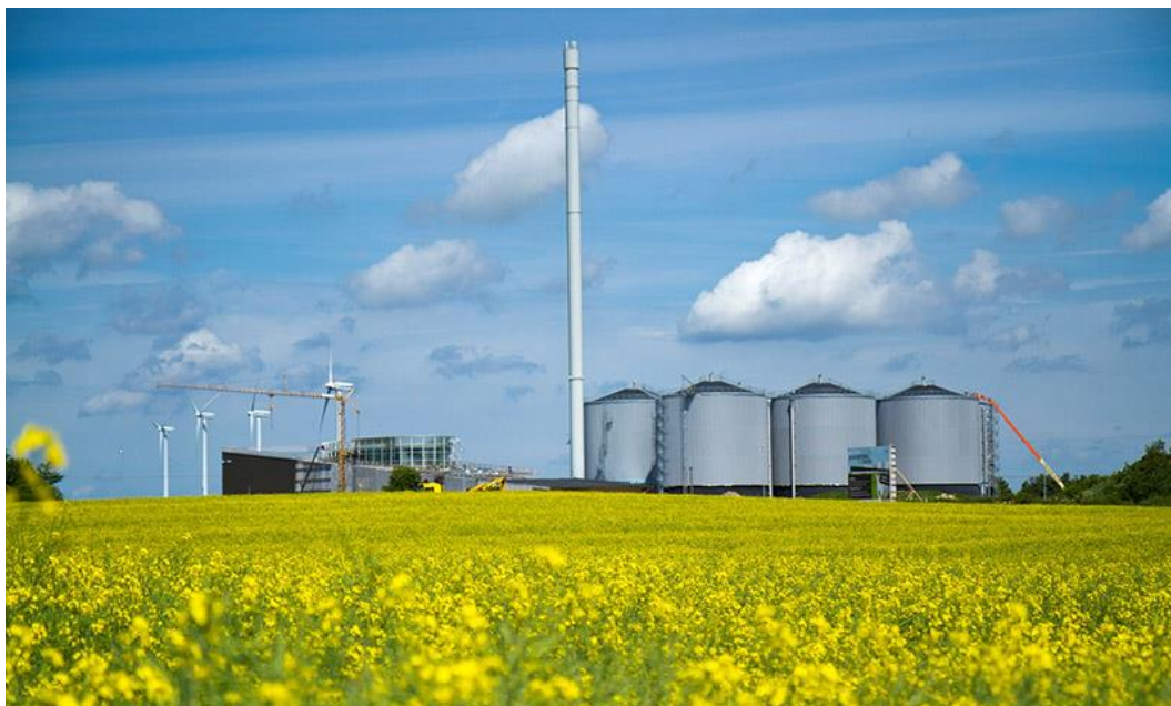
Рисунок 6.5 — Биогазовая установка, работающая на свалочном газе
