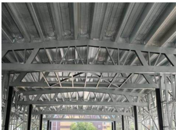
Рисунок 6 – Системы конструкций каркаса здания из ЛСТК. Мойка автомобилей в г. Самара, ноябрь 2024 г.
