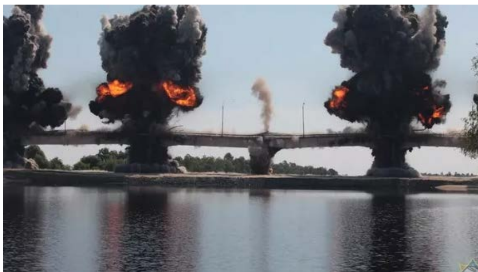
Рисунок 1 – Взрыв моста через реку Припять
