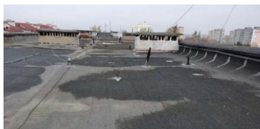
Рис. 4. Застой атмосферной воды на кровле Fig. 4. Stagnation of atmospheric water on the roof
