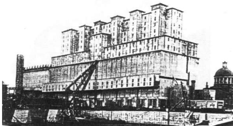
Рис. 7. Элеватор в Монреале, Канада
