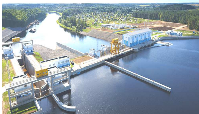
Рисунок 3 – Витебская ГЭС (вид с верхнего бьефа)
