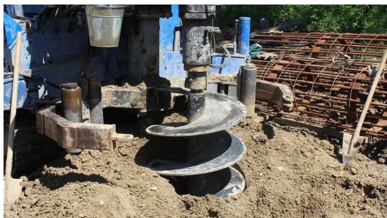
Рисунок 1 – Бурение скважины
