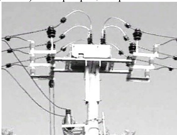
Рисунок 1 – Высоковольтный модуль реклоузера РВА/TEL "Таврида Электрик"
