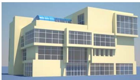
Рис. 2. Общий вид здания
