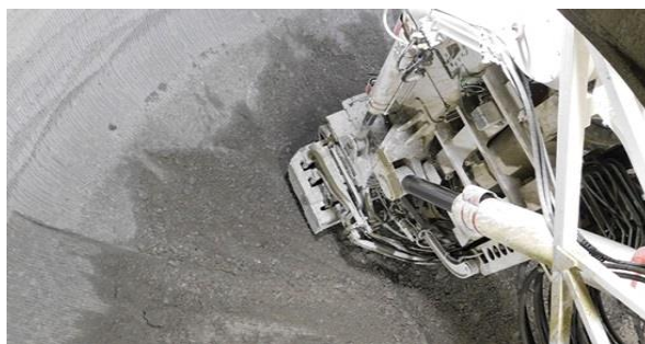
Рис."4 – Забой шахтного ствола при проходке СБР
