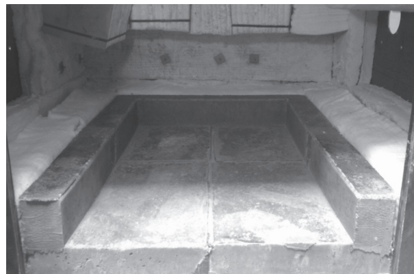
Рис. 8. Бордюры рабочего слоя печи
