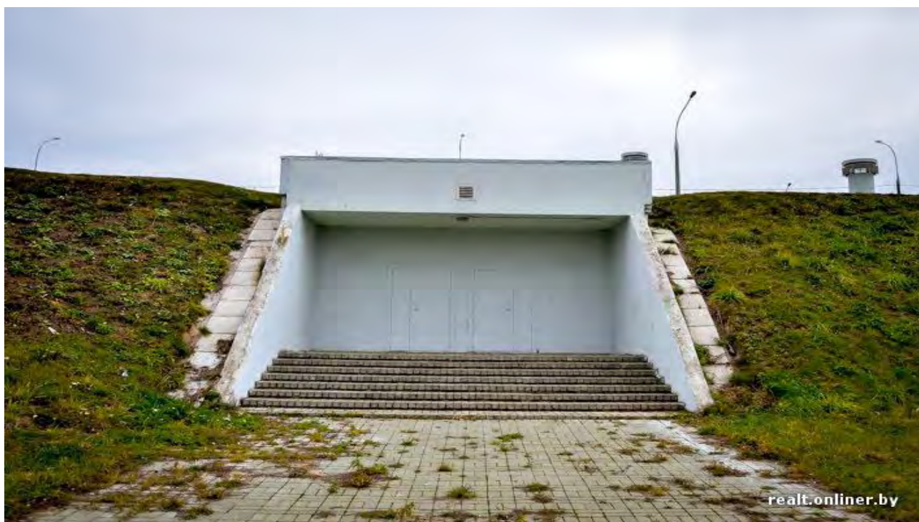
Рисунок 4 – Вход в неиспользуемый вестибюль станции «Борисовский тракт»
