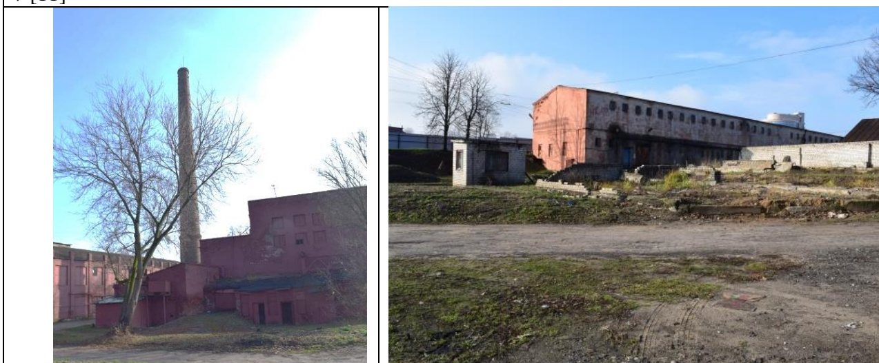
Рисунок 8. а – котельная; б – склады
