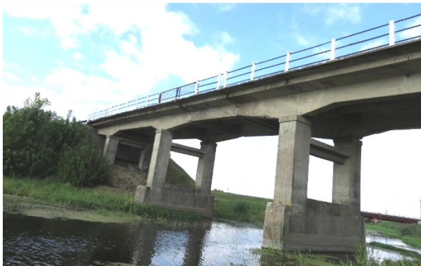
Рис. 3. Мост через р. Гривда на км 140,577 автомобильной дороги Р-2 Столбцы – Ивацевичи – Кобрин
