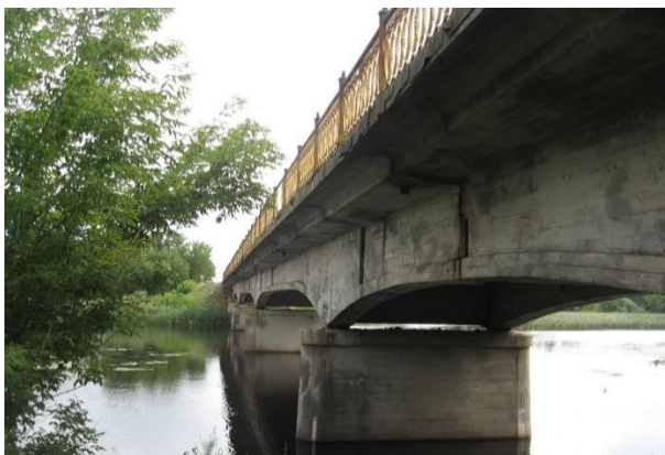
Рис. 2. Мост через р.Щара на км 125,40 автомобильной дороги Р-2 Столбцы – Ивацевичи – Кобрин
