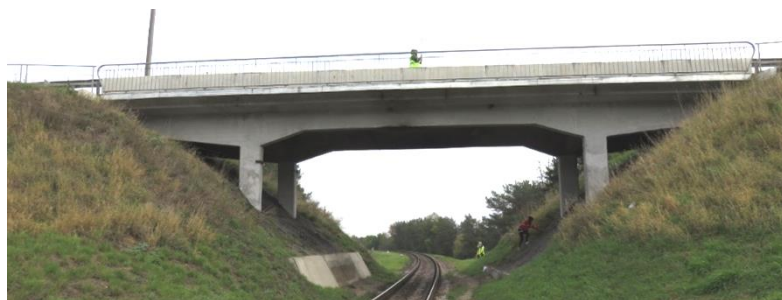
Рис. 1. Путепровод на км 81,071 автомобильной дороги Р-2 Столбцы – Ивацевичи – Кобрин
