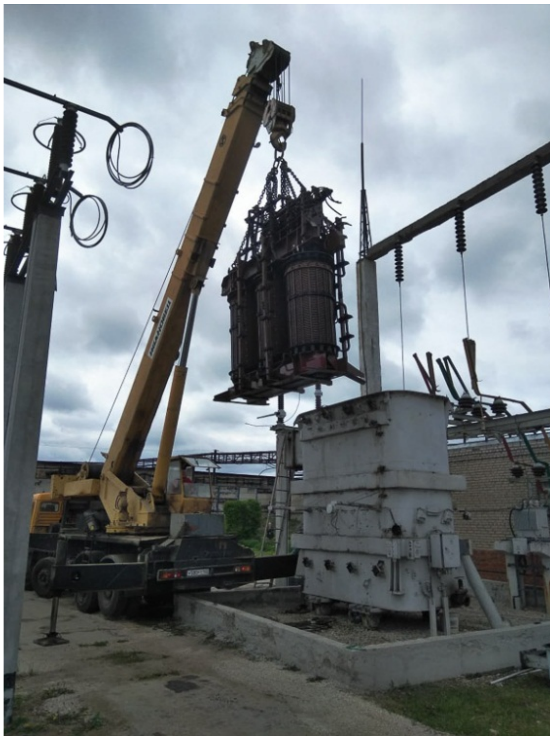
Рисунок 1 – Демонтаж трансформатора 115/10.5 кВ
