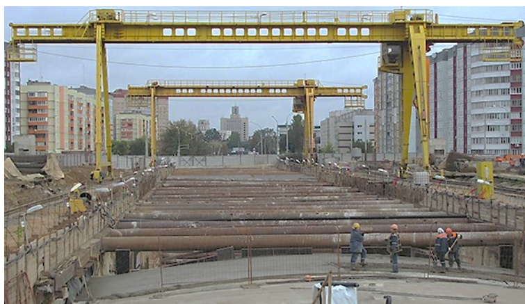
Рисунок 1 – Козловые краны КК-К-20 на строительстве 1 участка 3 линии Минского метрополитена
