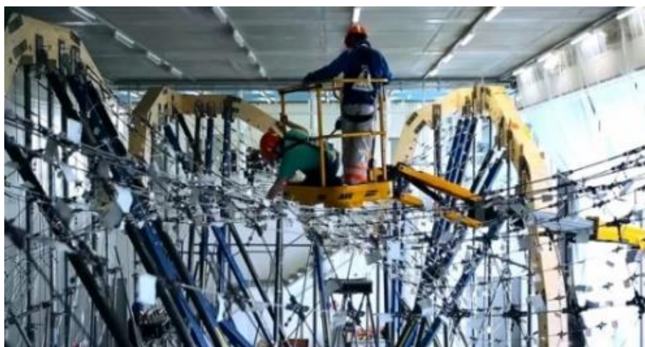
Рисунок 7 – Установка тросов
