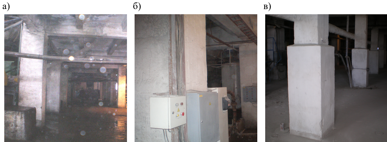
а – усиленные железобетонные колонны 1-го этажа; б – усиленные железобетонные колонны 2-го этажа; в – местное усиление железобетонных колонн 2-го этажа
