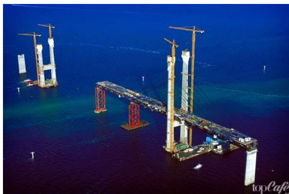
Рисунок 3 – Строительство Эресуннского моста
