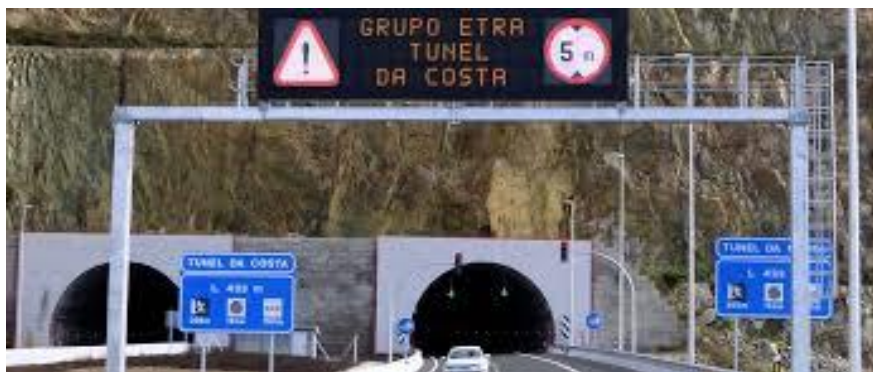
Рисунок 7 – Информационное табло и динамические дорожные знаки на въезде в тоннель
