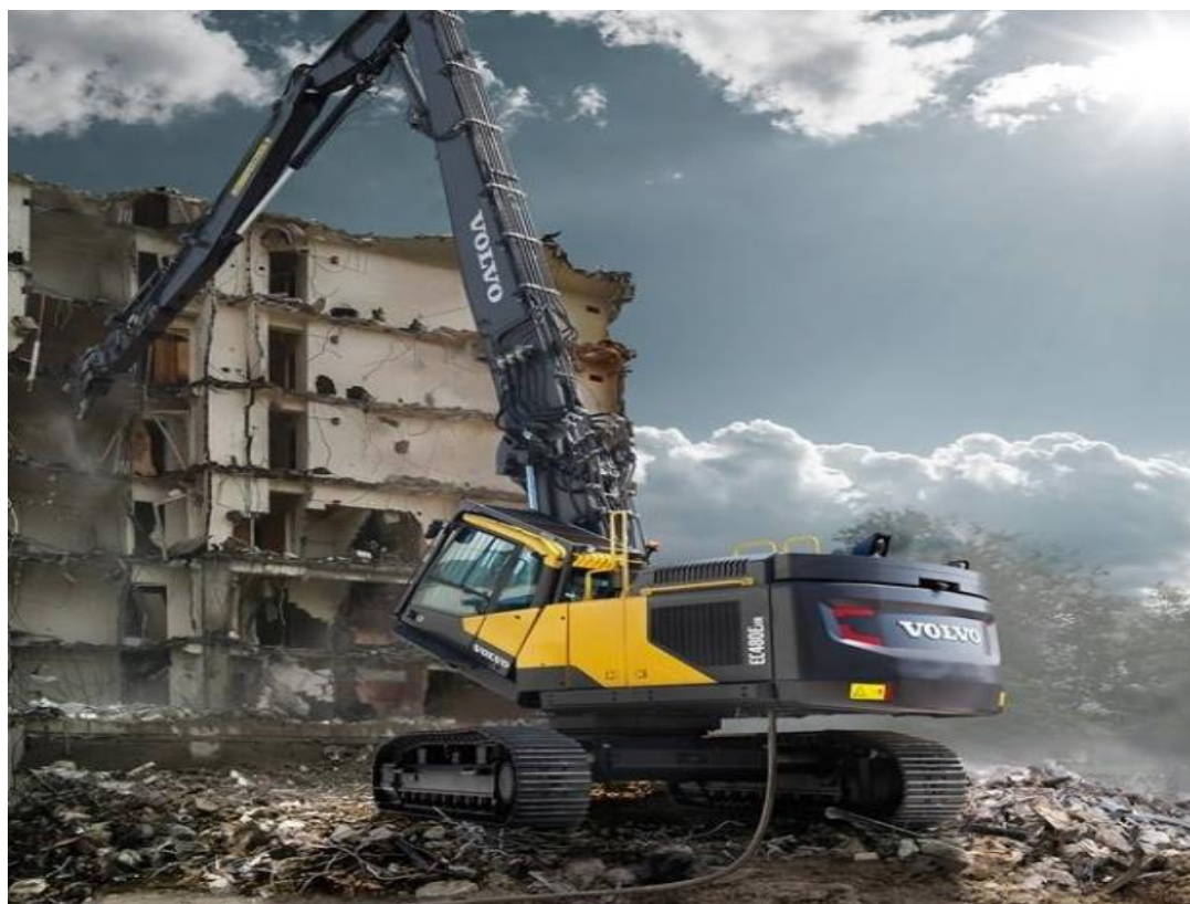
Рисунок 1 – Экскаваторы Volvo для сноса зданий и сооружений
