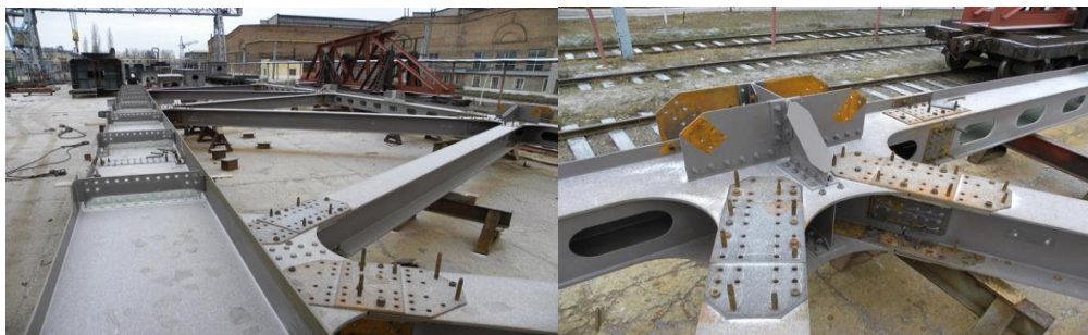
Рисунок 3 – Контрольная сборка части решетки главной фермы
