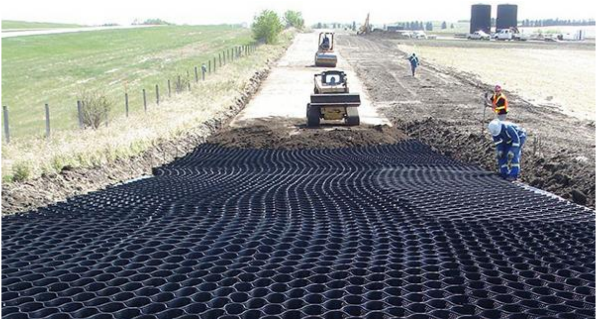
Рисунок 6 – Применение решётки Геовиб в строительстве дороги
