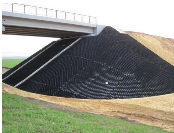
Рисунок 4 – пример укрепленного георешеткой откоса моста
