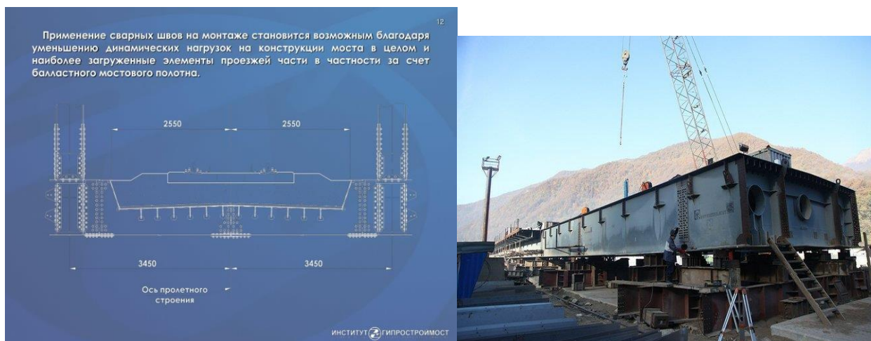
Рисунок 2 – Сварные швы ортотропной плиты
