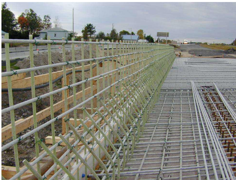
Рисунок 1 – Применение стеклопластиковой арматуры
