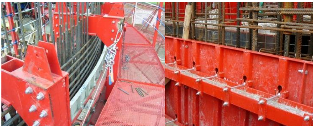
Рисунок 2 – Конструкция скользящей опалубки
