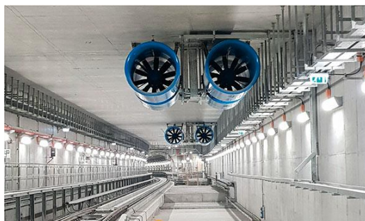
Рисунок 13 – Струйный вентилятор
