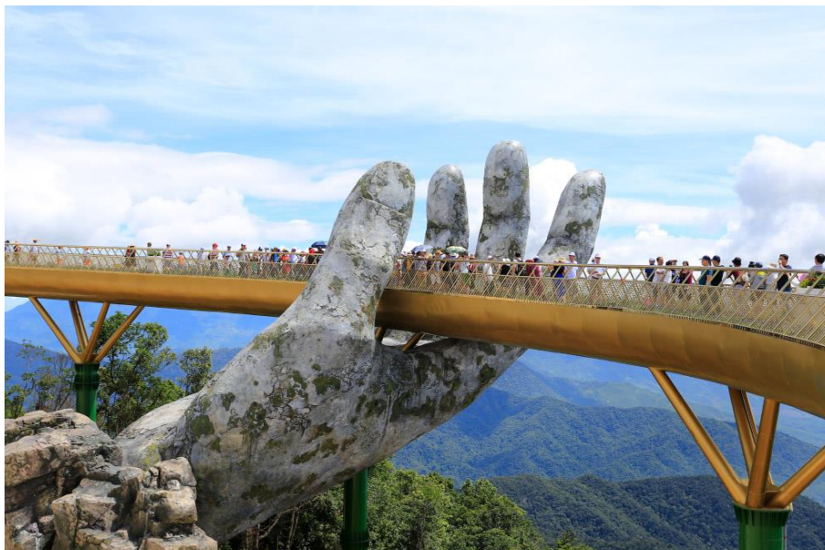
Рисунок 3 – Опоры “Золотого моста”
