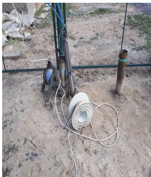
Рисунок 4. Оборудование для прокачки экспериментальных скважин в д. Приморье
