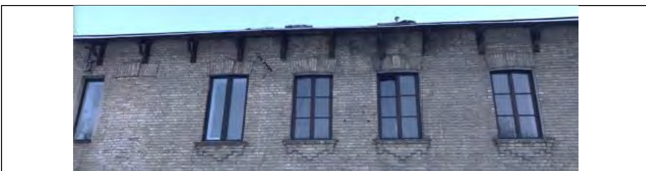
Рисунок 32. Улица А. Мицкевича, 13. Фигурные подкосы
