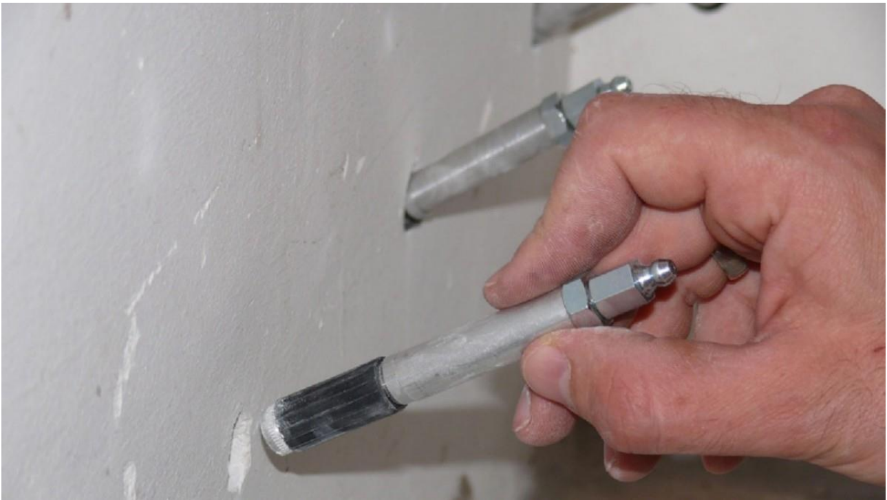
Рисунок 2 – Установка тьюбинга
