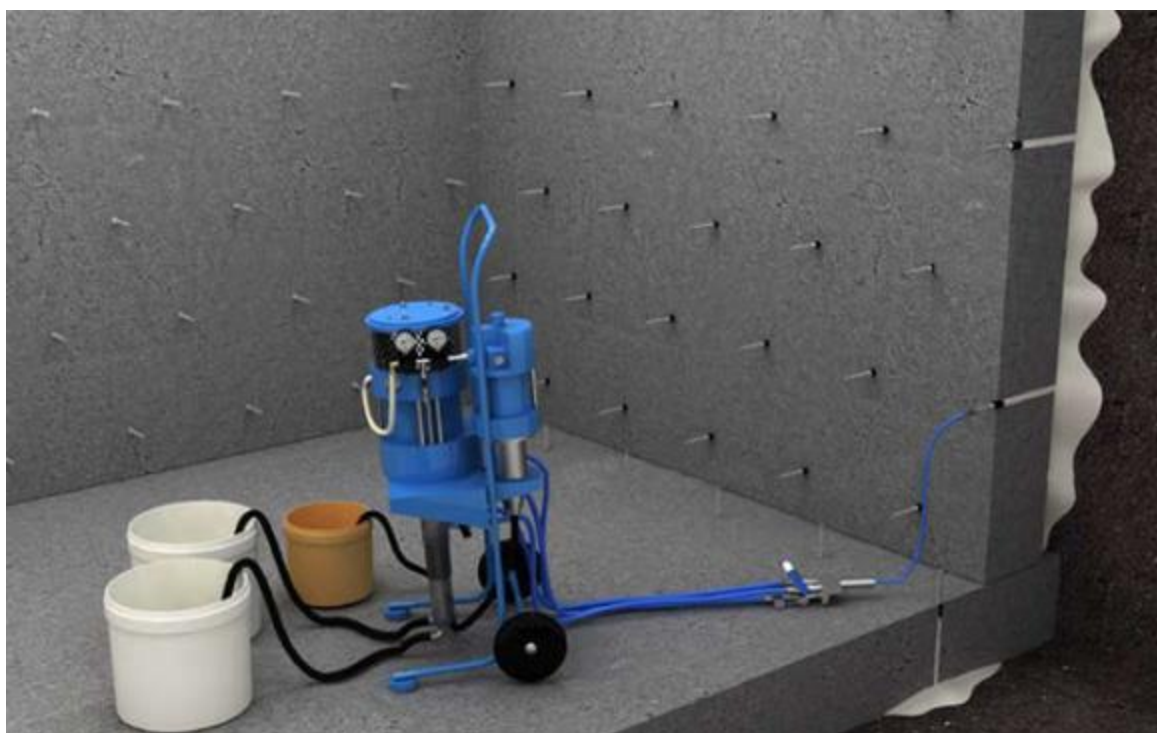
Рисунок 1 – инъектирование состава в стену фундамента
