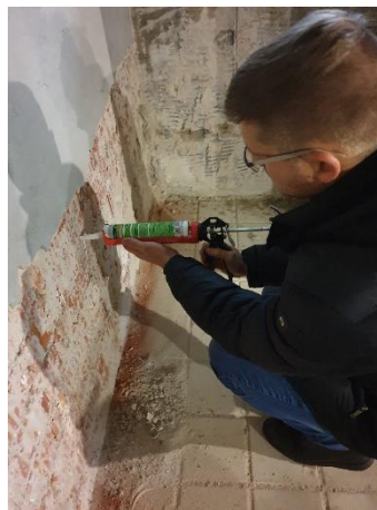
Рисунок 3 – Инъектирование состава
