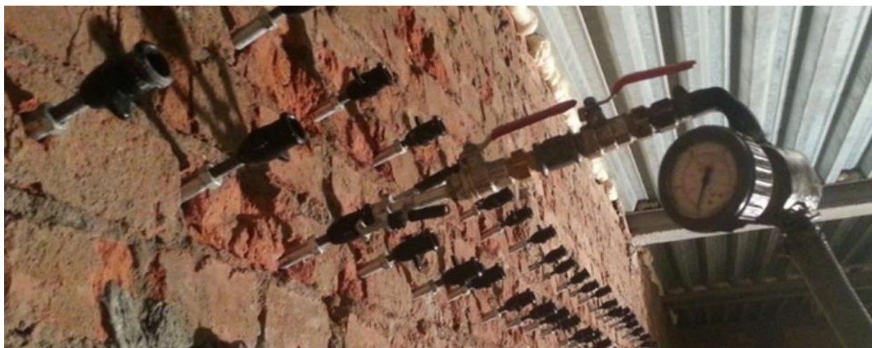
Рисунок 2 – подача смеси под давлением
