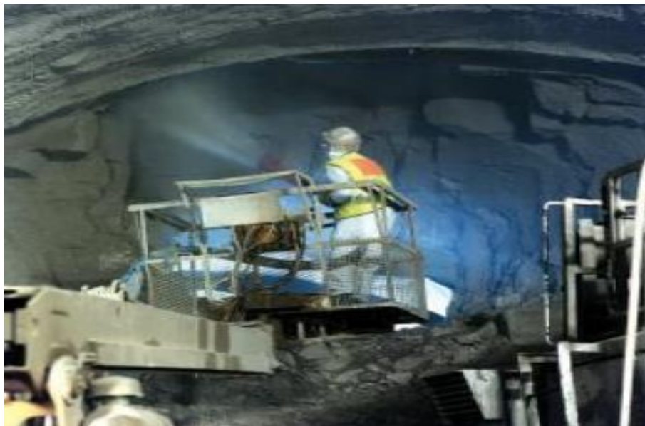
Рисунок 2 – распыление гидроизоляции Cormix
