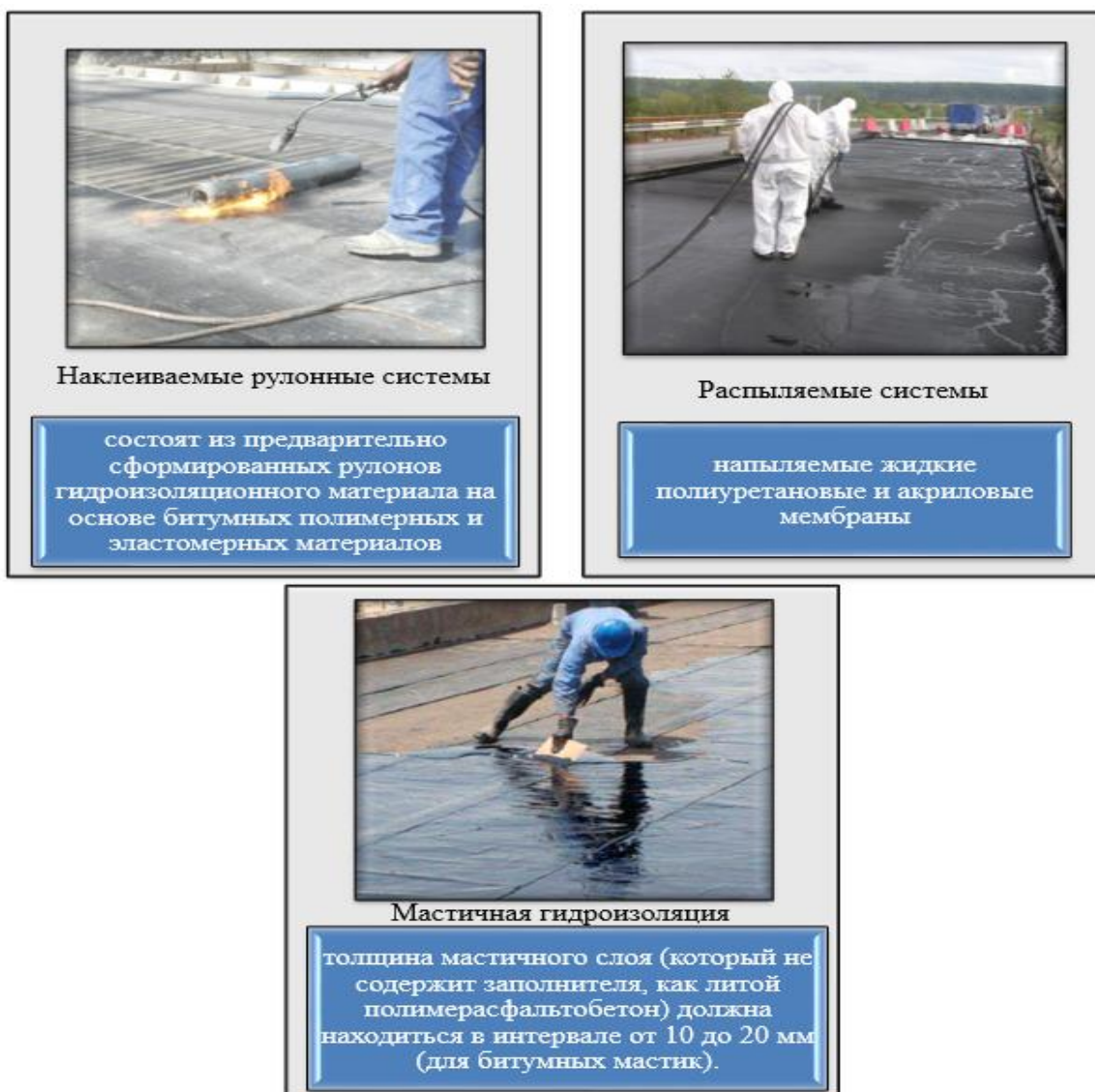
Рисунок 2 – Три основных типа гидроизоляции
