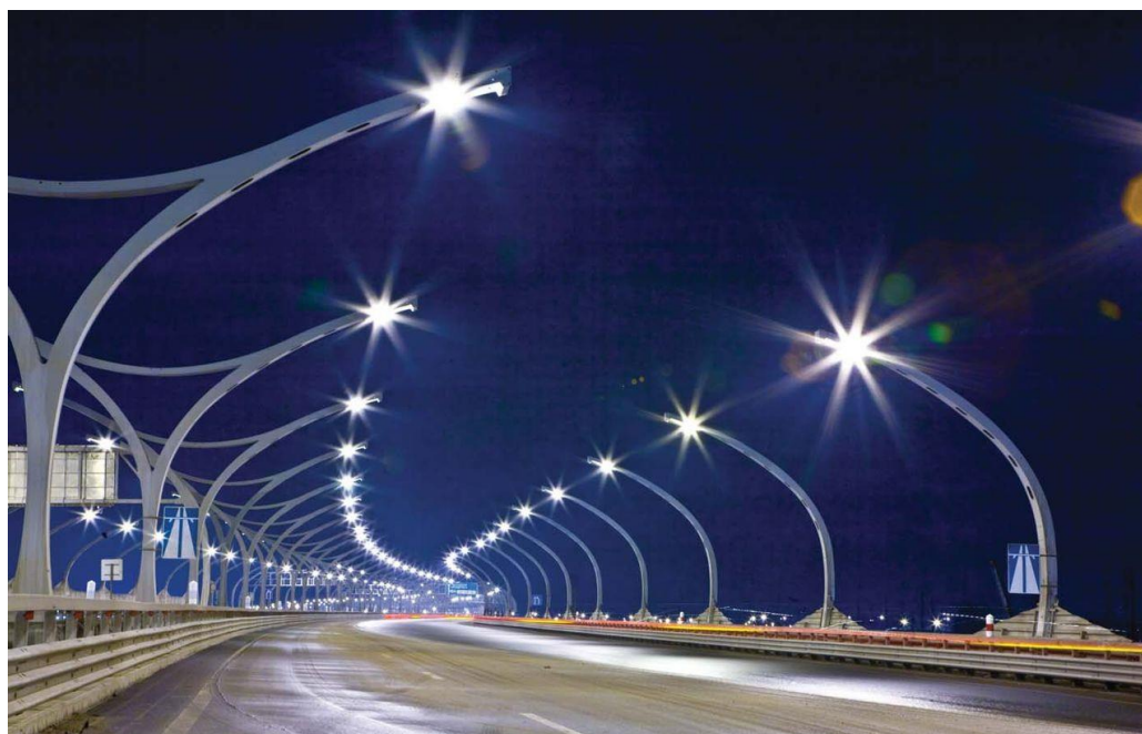
Рисунок 1 – Освещение автомобильных дорог в темное время суток
