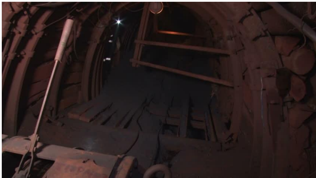
Рисунок 2 – Пыль в тоннеле
