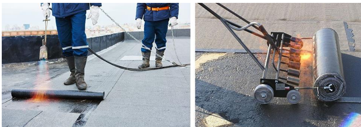
Рисунок 2 – Наплавление гидроизоляции
