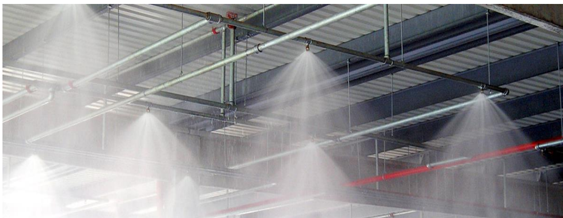
Рисунок 1 – Спринклерная система пожаротушения
