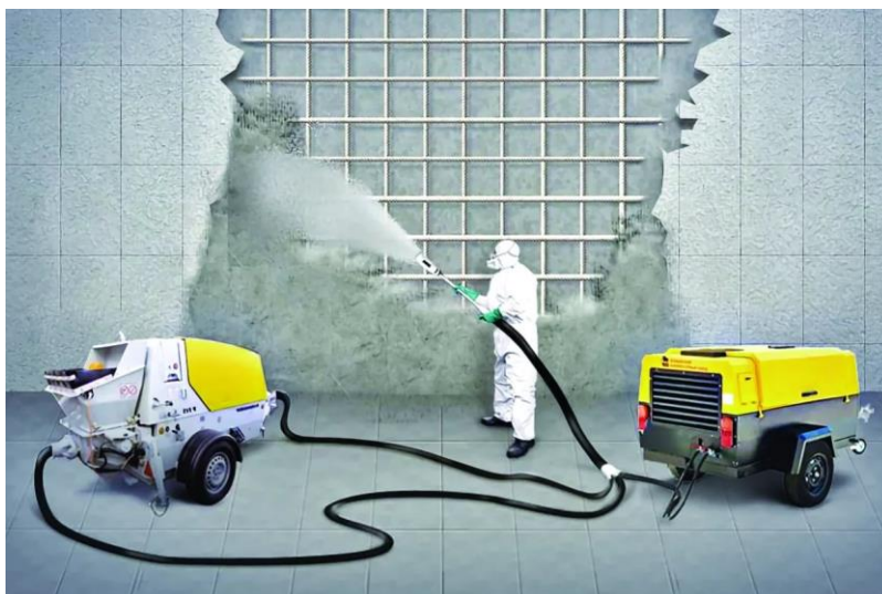
Рисунок 3 – торкретирование поверхности
