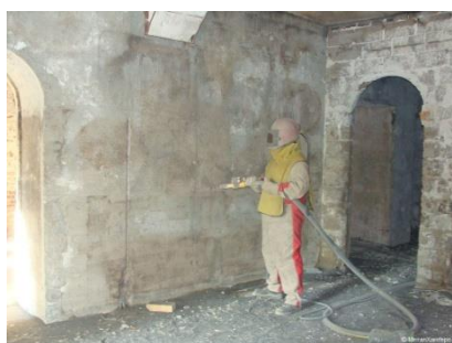
Рисунок 3 – Пескоструйная сухая обработка
