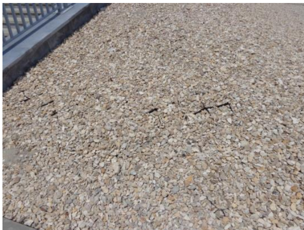
Рисунок 9 – Слой щебня и георешётка
