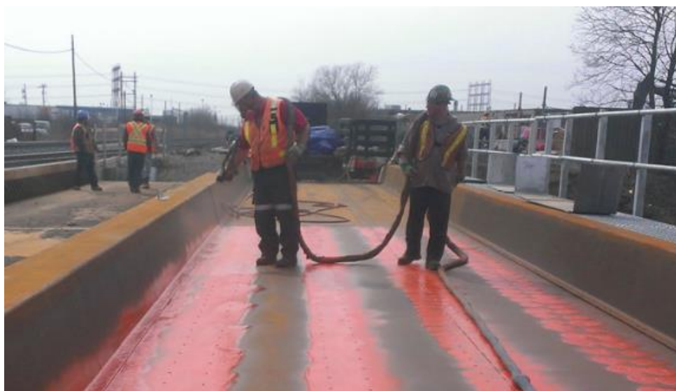
Рисунок 1 – Производство работ по укладке гидроизоляционной мембраны
