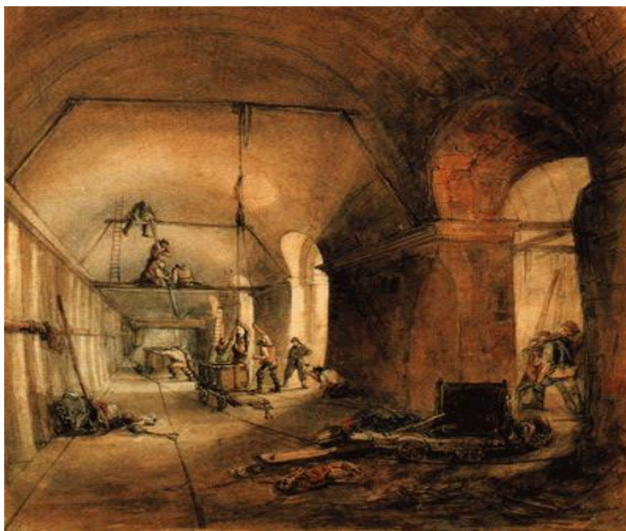
Рисунок 1 – Строительство тоннеля под р. Темза
