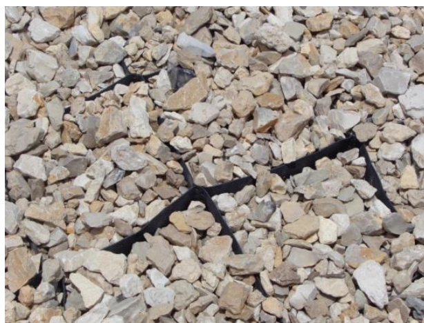
Рисунок 10 – Георешётка заполненная щебнем
