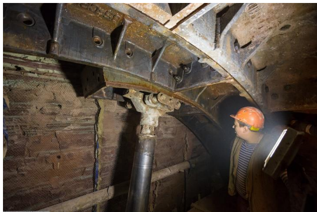
Рисунок 2 – Установка тубинга
