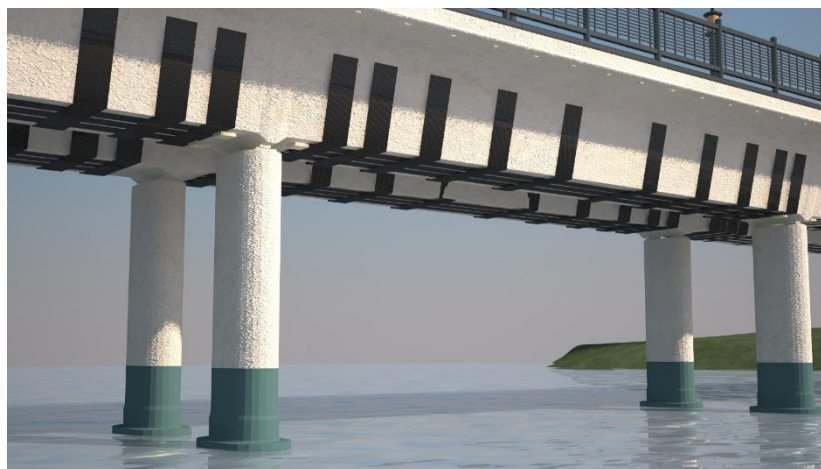
Рисунок 2 – Схематичное изображение пролета моста, усиленного полимерными композиционными материалами [3]
