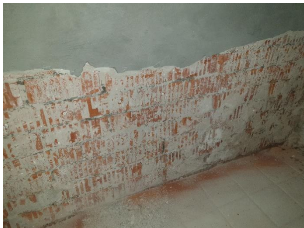
Рисунок 2 – Подготовка основания
