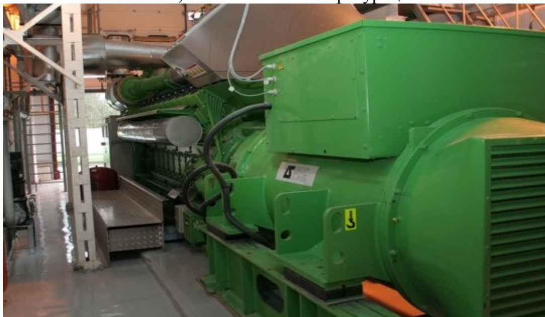
Рисунок 2. Газопоршневой агрегат
