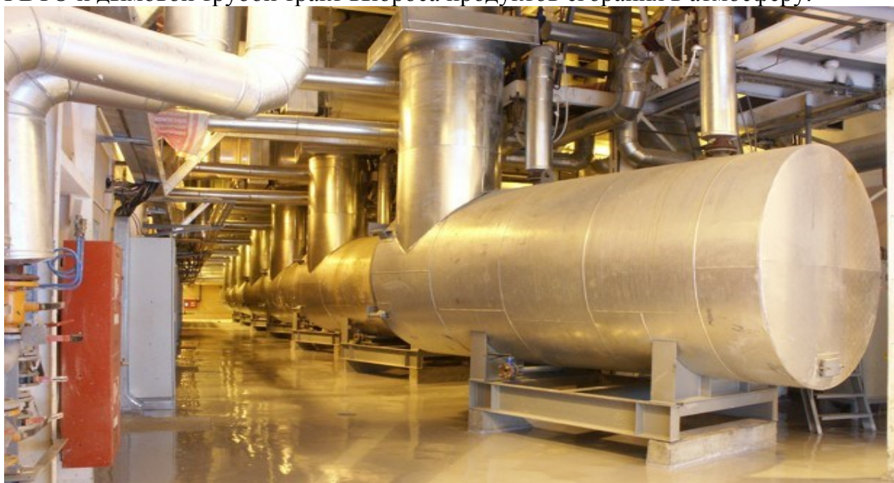
Рисунок 1. Газоводяные теплообменники
