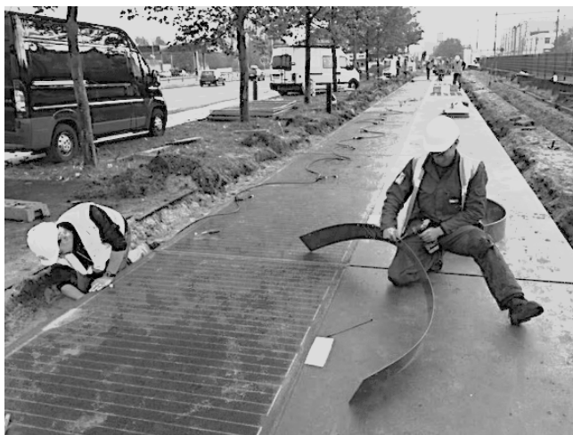
Рис. 1. Велослорожка из переработанных пластиковых отходов
