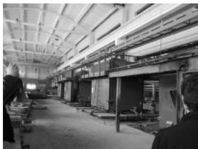
Рис. 19. Кассетные установки для производства шахт лифтов
