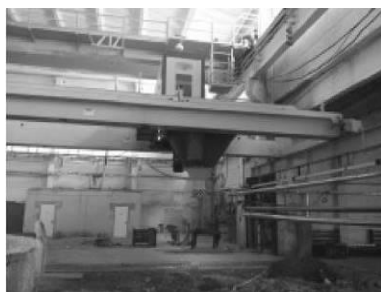
Рис. 6. Бетоноукладчик мостового типа
