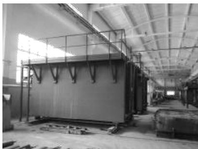
Рис. 18. Кассетная установка для производства вентиляционных блоков
