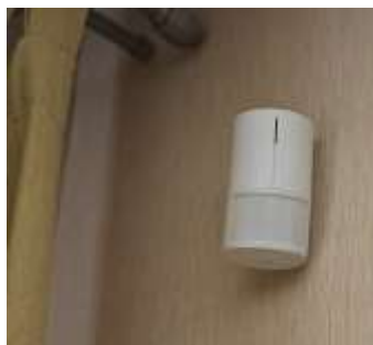
Рисунок 2 – Установленный датчик движения в квартире
