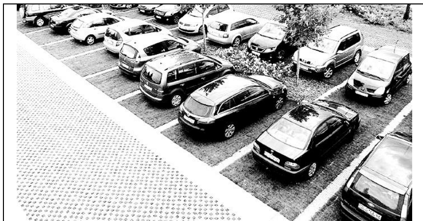
Рис. 4.14. Экопарковка с укрепленным газонным покрытием
