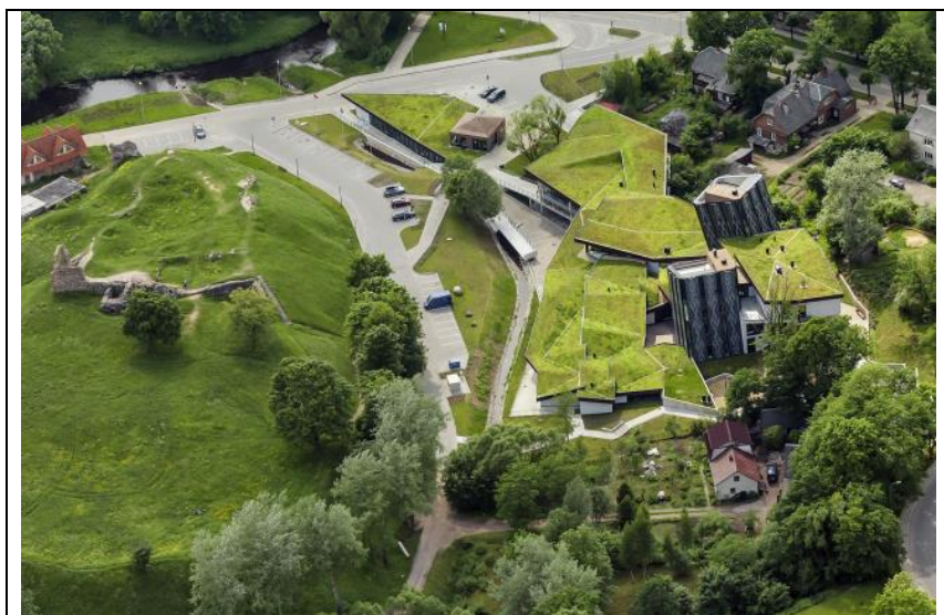
Рис. 4.13. Покрытия крыш из дернины. Молодежный центр «Zeimuls», г. Резекне (Латвия)
