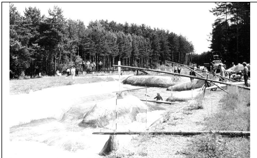
Рис. 4.17. Канал в зоне отдыха «Минское море», который необходим для улучшения водообмена в водохранилище, и одновременно является трассой водного слалома
