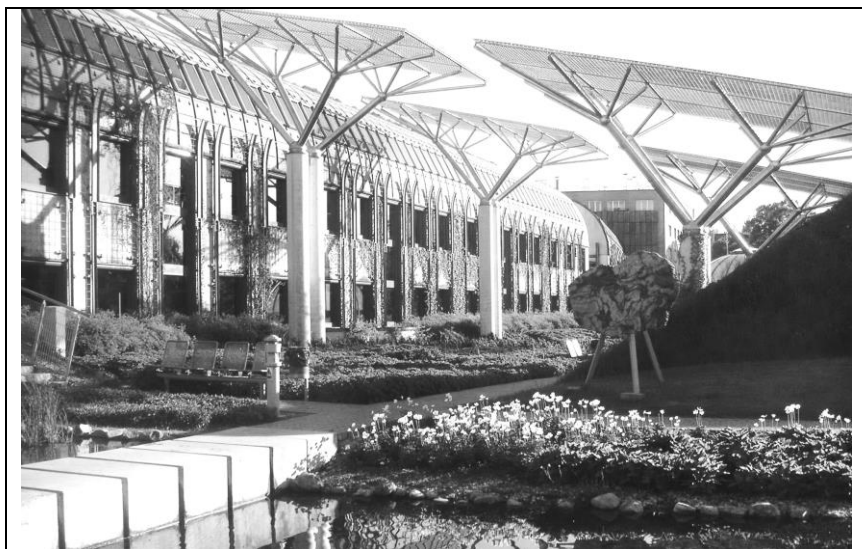
Рис. 1.2. Использование принципов «зеленого» градостроительства в современной застройке – комплекс библиотеки Варшавского университета (энергоэффективное инженерное оборудование, озелененная эксплуатируемая крыша, вертикальное озеленение стен, наличие парковой зоны), архитекторы М. Будзински, З. Вадовски
