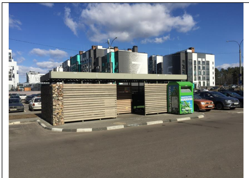
Рис. 6.9. Павильон для раздельного сбора мусора, расположенный рядом с парковкой личных автомобилей жильцов, жилой район «Новая Боровая» в Минске
