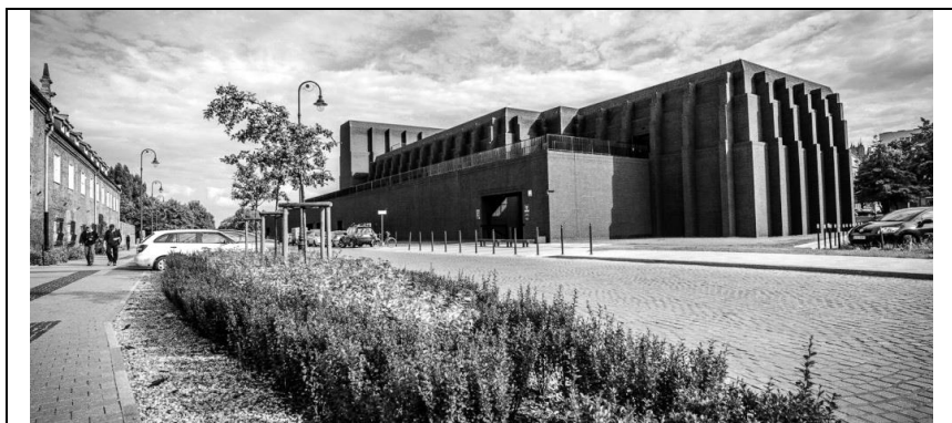
Рис. 5.5. Здание Шекспировского театра с раскрывающейся крышей, Гданьск (Польша), архитектор Р. Рицци
