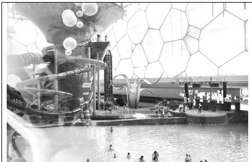
Рис. 3.7. Олимпийский центр водных видов спорта в Пекине с фасадами из полупрозрачной фторполимерной пленки
