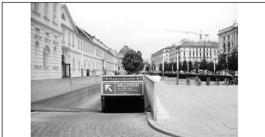
Рис. 3.2. Въезд а подземный паркинг в Музейном квартале в историческом центре Вены (Австрия)
