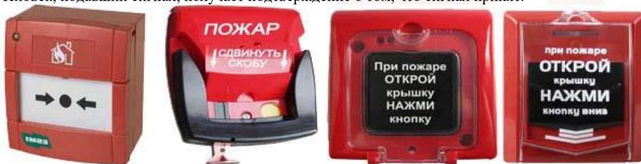
Рис. 18.8. Ручные пожарные извещатели
