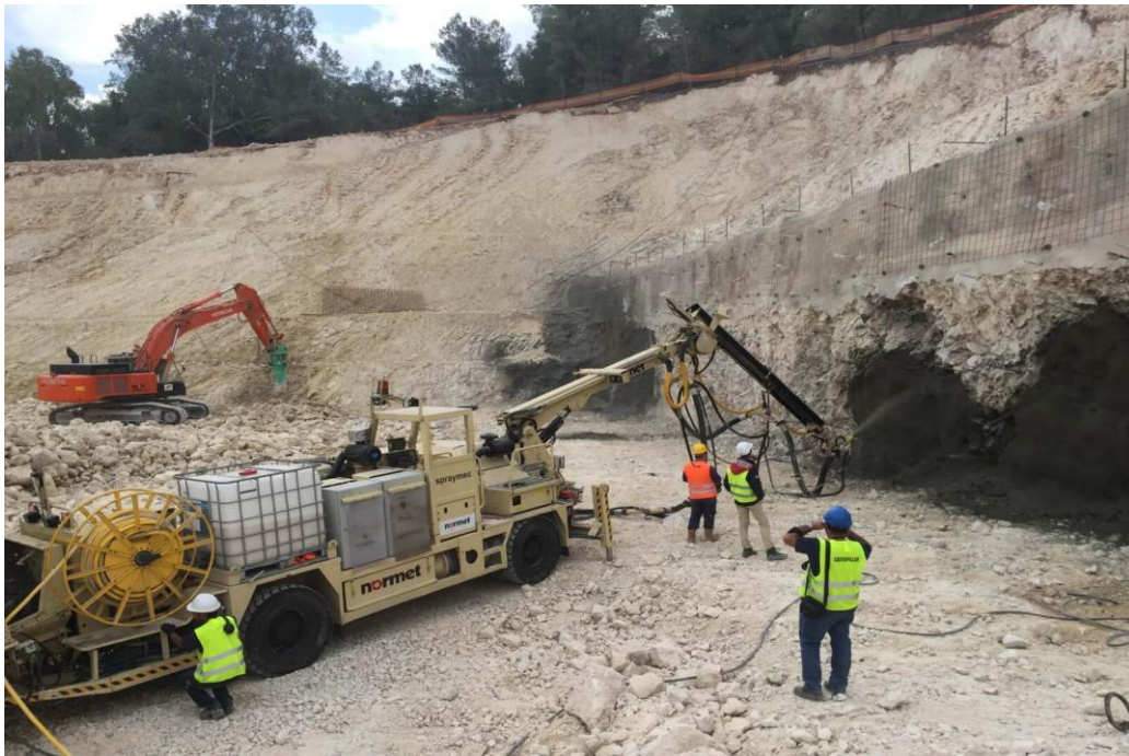
Рисунок 4 – Нанесение набрызг-бетон
