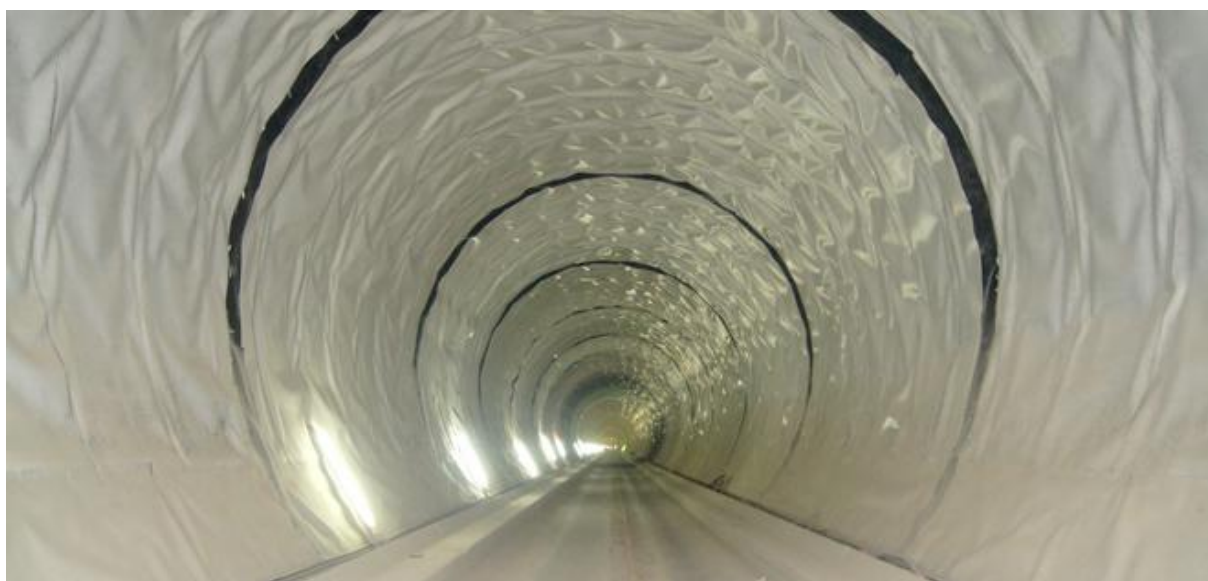
Рисунок 1 – Тоннель Коральм в Австрии
