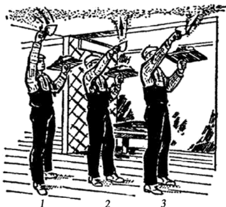
Рис. 13.6. Нанесение раствора на потолок набрасыванием: 1 – через голову; 2 – над собой; 3 – от себя
