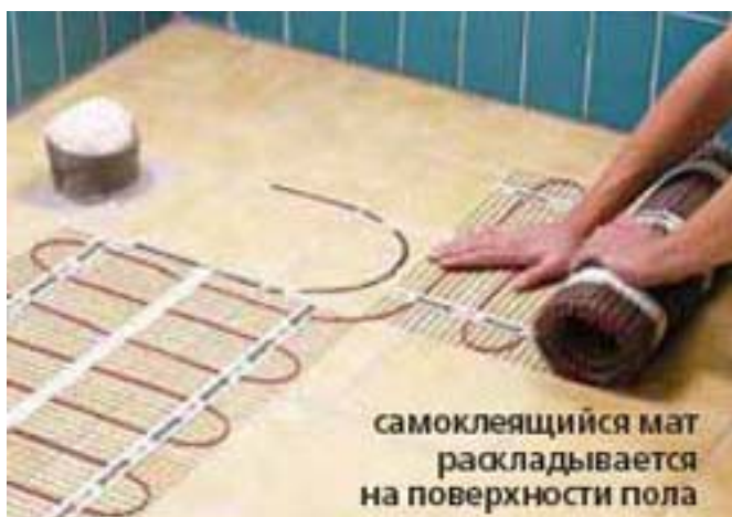
Рис. 17.10. Укладка электрических нагревательных матов
