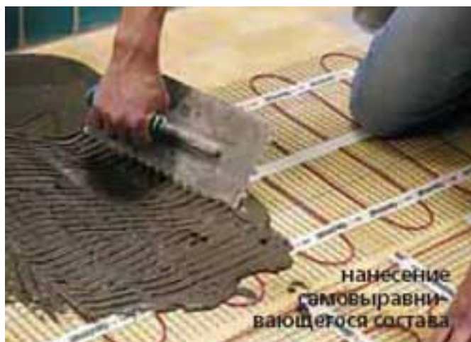
Рис. 17.11. Устройство стяжки под полы
