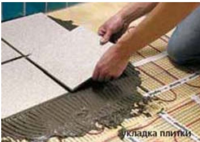
Рис. 17.12. Укладка пола из плитки
