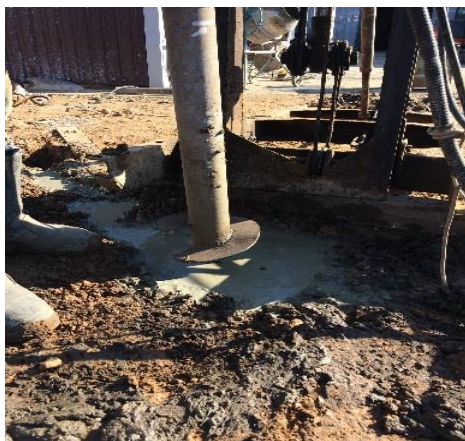
Рис. 3.Погружение винтовой сваи
