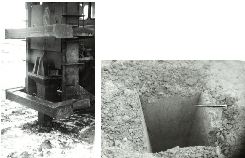
Рис. 2. Общий вид оборудования (слева) и вытрамбованной скважины (справа)
