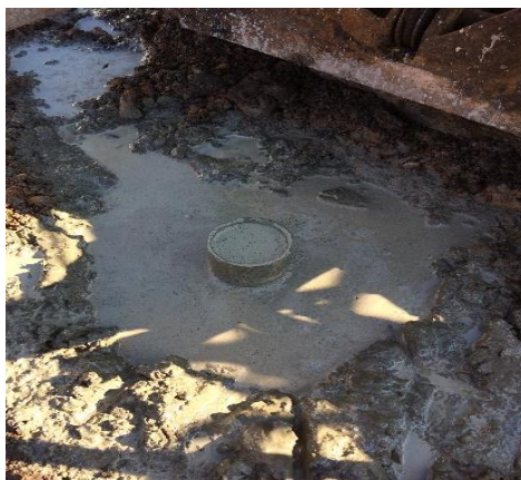
Рис. 4. Готовая свая
