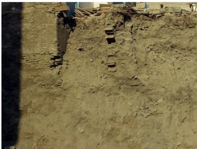
Рис. 2. Пример фундаментов зданий XIV века постройки в г. Бухаре
