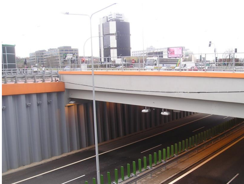
Рис. 5. Автодорожный виадук, г.Келце
