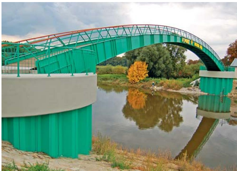
Рис. 6 – Причалы пешеходного моста, г.Нова Суть
