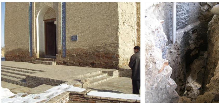
Рис. 1. Мавзолей Бурханиддина Сагарджи в г. Самарканде (XIV в). Цокольная часть здания и ленточные фундаменты.
