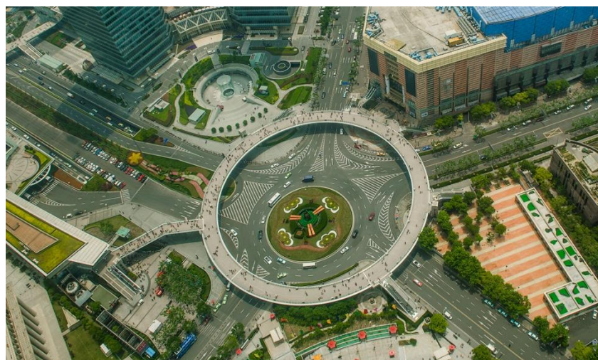
Рисунок 5 - Пешеходный мост в Шанхае
