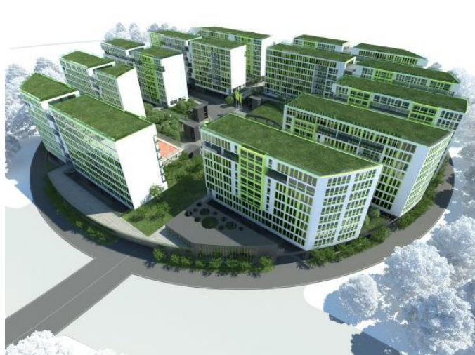
Рисунок 2 - Пример организации транспортного движения в жилом квартале. Архитектурная концепция жилого квартала в Сколково, г. Москва. Жилое пространство располагается на платформе, под которой расположены автостоянки и проходит транспортное сообщение
