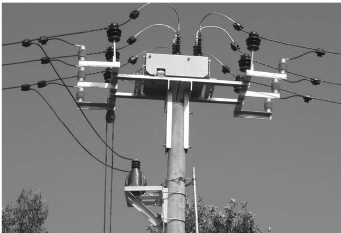
Рисунок 1 – Вакуумный реклоузер
