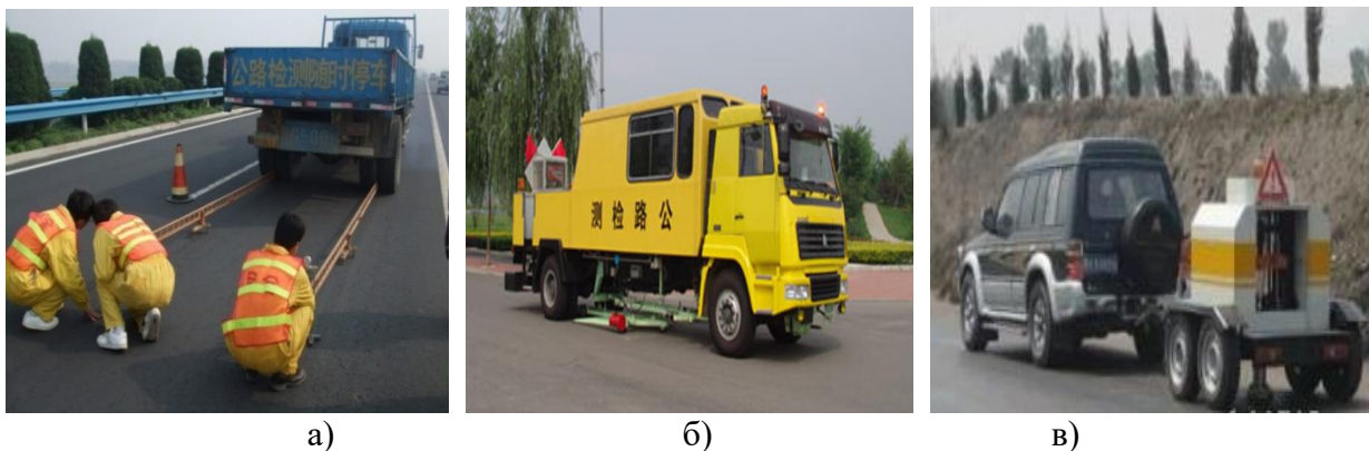
Рисунок 3 – способы измерения упругого прогиба
