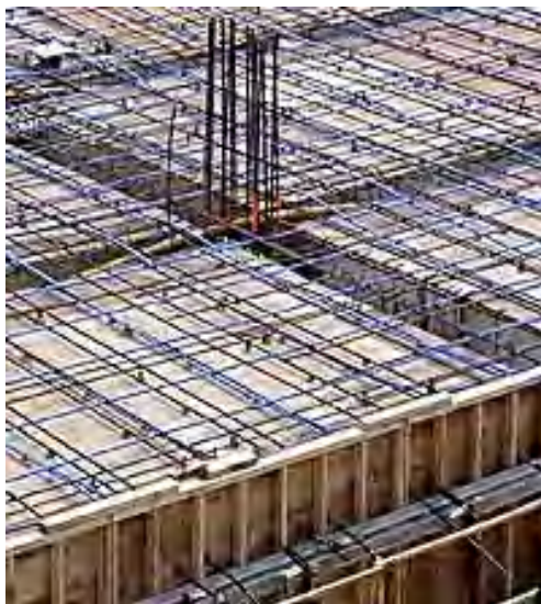
Рис. 6.1. Устройство облегченного перекрытия
