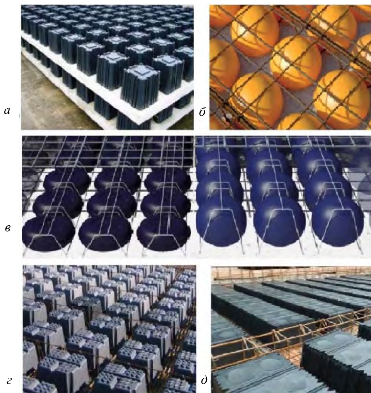
Рис. 6.2. Системы с применением полимерных вкладышей: a – Airdeck; б – BubbleDeck; в – Cobiax; г – U-Boot Beton; д – U-Bahn Beton
