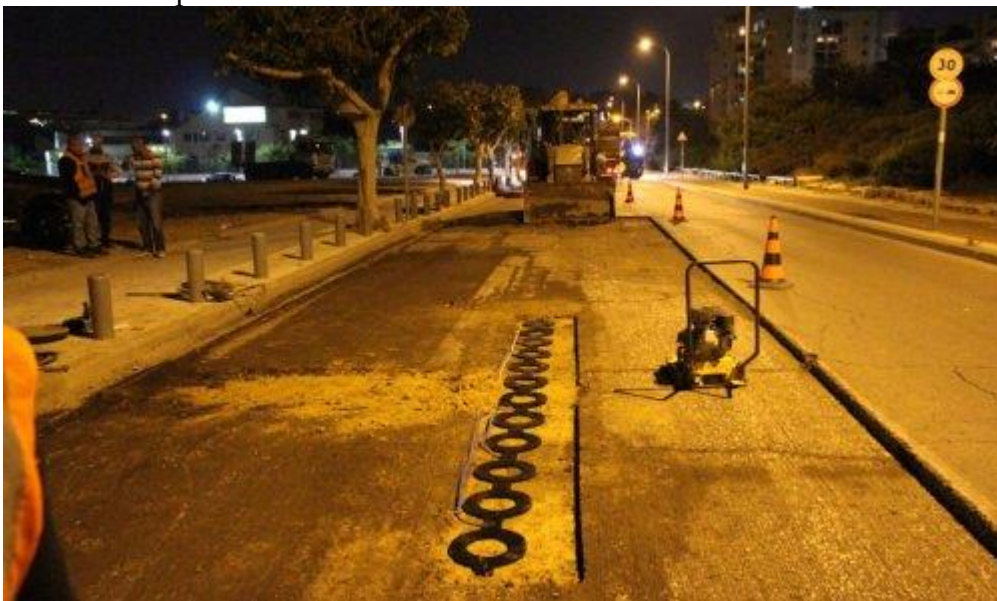
Рисунок 2. Прокладка дороги в настоящее время в Тель-Авиве
