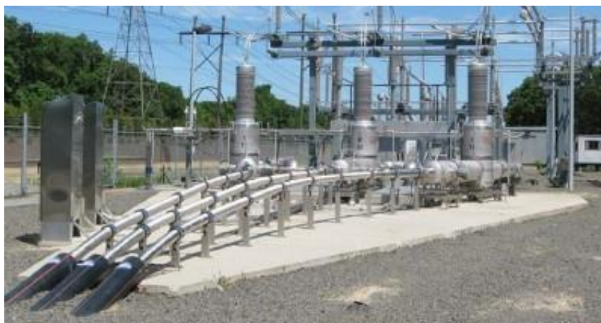
Рисунок 4. ВТСП-кабель 138 кВ (2400 А) длиной 660 м.
