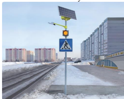
Рисунок 1. Автономное освещение пешеходного переходы
