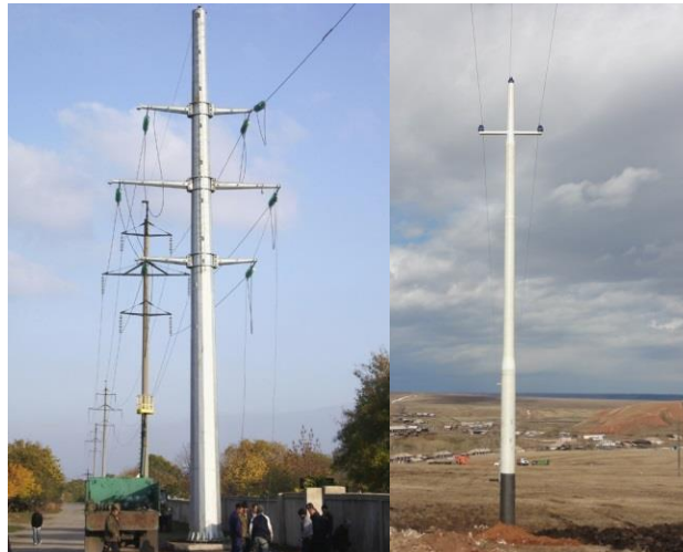
Рисунок 6. - Опоры из стальных труб
