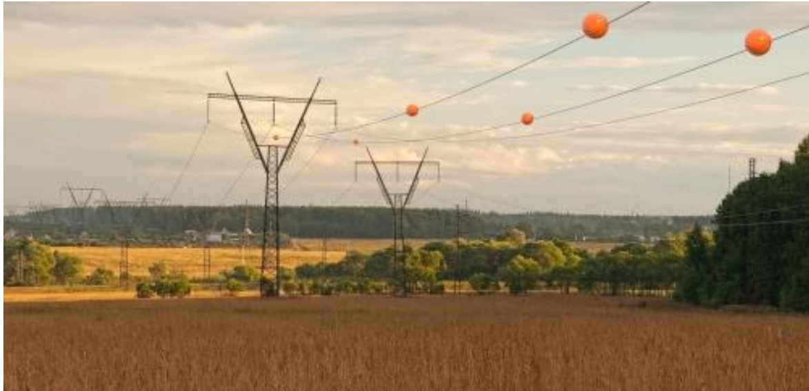
Рисунок 4. Маркеры для воздушных линий электропередачи
