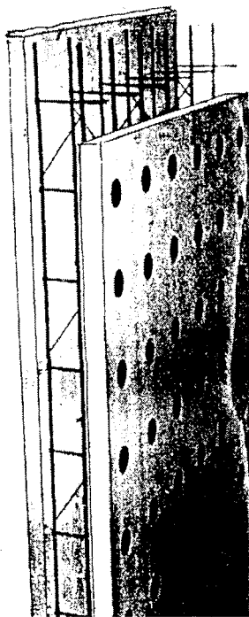
Рис. 4.12. Несъемная опалубка из пенополистирола
