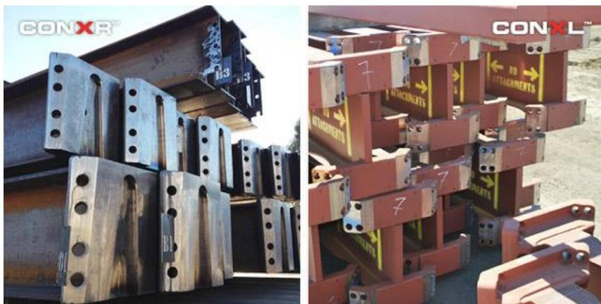
Рисунок 3 – Опорные части балок систем ConXL и ConXR
