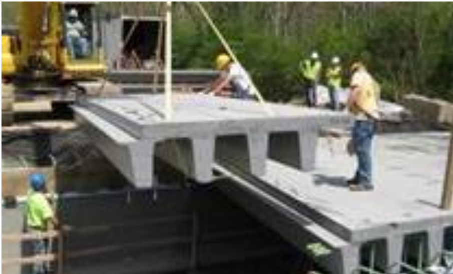
Рисунок 1 – Установка композитной плиты ограничивается использованием одного экскаватора
