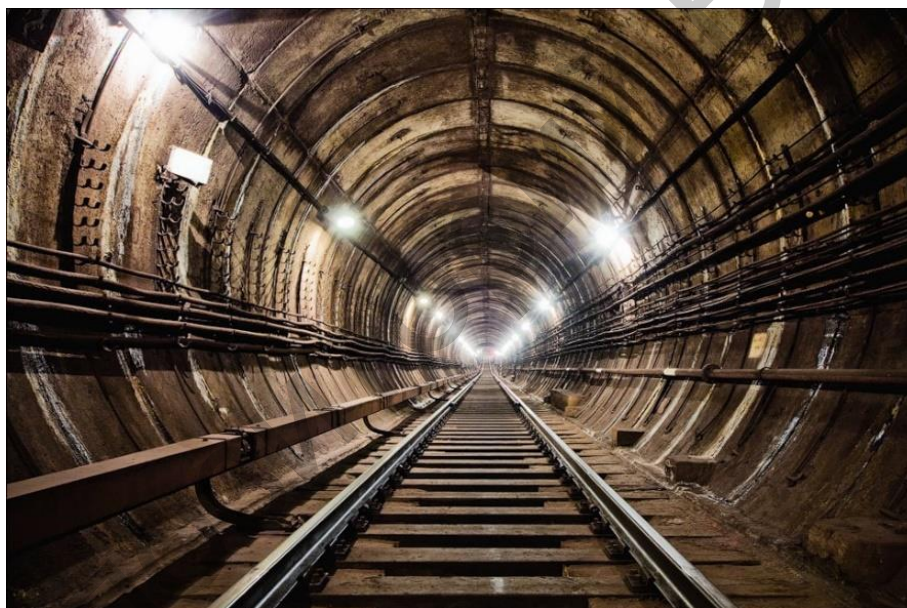
Рисунок 1 – Вид тоннеля изнутри
