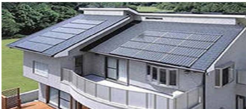
Рис. 2.24. Автономная крышная солнечная электростанция
