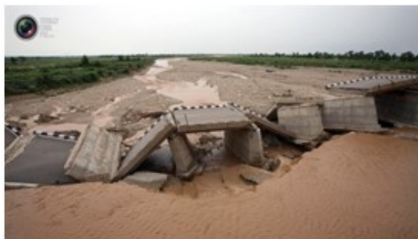
Рисунок 2 – Разрушенный мост в Индии
