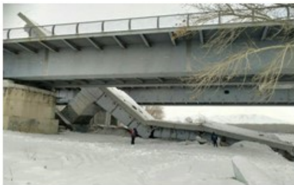
Рисунок 1 – Мост через реку Иртыш в г. Усть-Каменогорск
