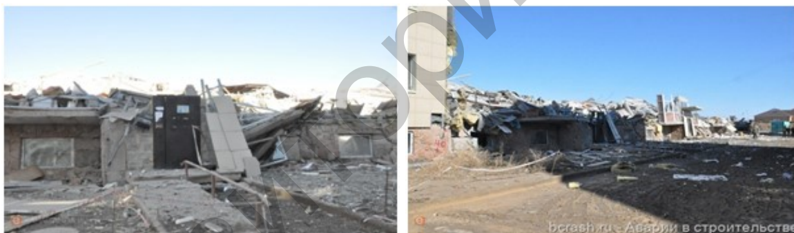
Рисунок 3 – Разрушенный дом в Караганде
